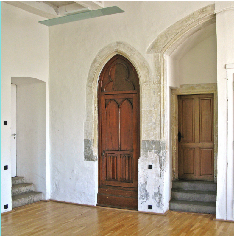
Ehemalige Kaminnische - heute mit Tür zum Saal Ehemalige Tür wurde zum Wandschrank
