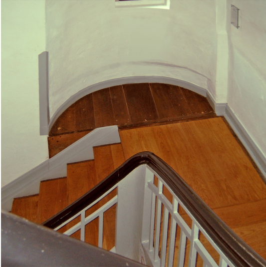
Treppe mit Rundung vom alten Treppenturm
