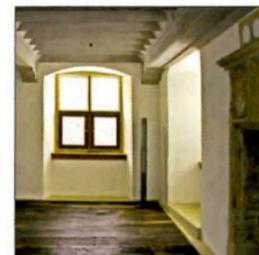
Dieser Raum bildet ein Zwischengeschoss. Seine Decke ist etwa um einen Meter versetzt zu der der Nachbarräume. Der Zugang erfolgt durch eine nachträglich eingebaute Tür. Ursprünglich betrat man das Zimmer durch den Treppenturm.
